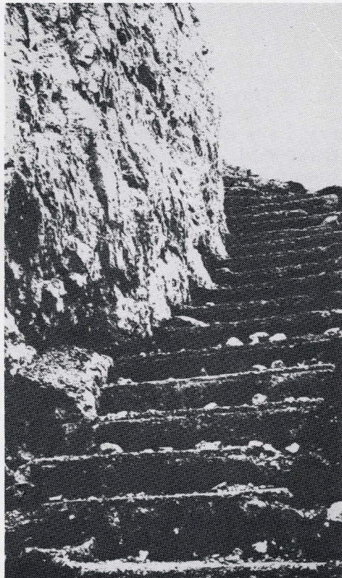
Particolare della scalinata in cemento della Prima Guerra Mondiale, che sale sulla Batognica.
